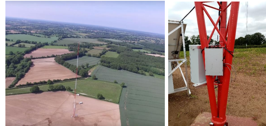
Figure 12: Vue d'ensemble du mât (@maszty.net Kodron) et vue du boîtier contenant l'enregistreur fixé sur le mât.
